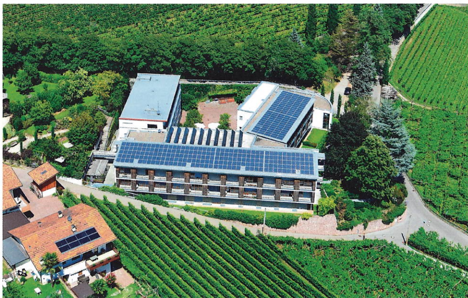
Blick auf die bereits bestehende PV Anlage
