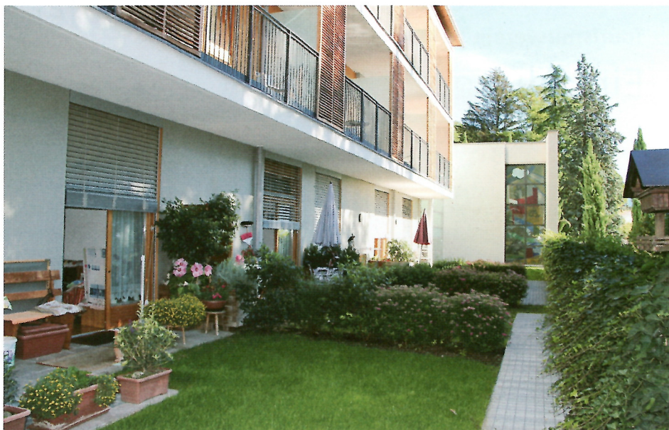
Die vier Altenwohnungen befinden sich im Parterre und sind nach Osten ausgerichtet.
